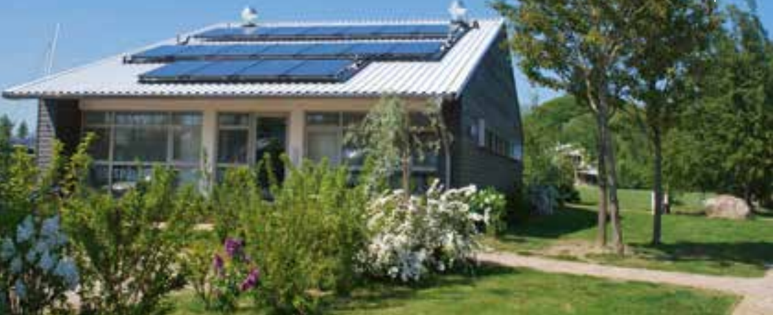
Nutzung der Sonnenenergie auf der Insel Rügen: Energiezentrale im Jaich
