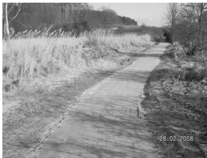
Wanderweg während des Ausbaus (wassergebundene Decke)
