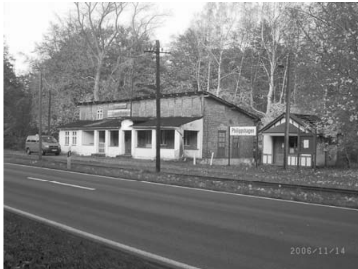
Zustand des Denkmalschützen ehem. Gepäck- u. Fahrkartenhäuschen
