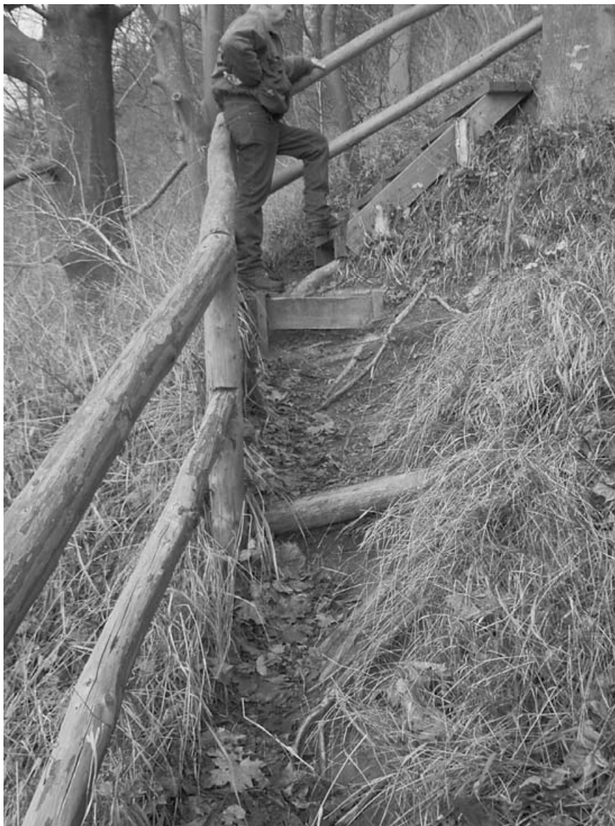
Aufstieg wird geschlossen und zurückgebaut
